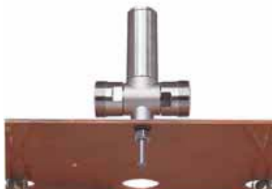
Рис. 4. Установка грозозащиты с помощью шпильки на шину уравнивания потенциалов
