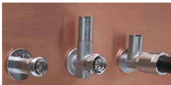
Рис. 2. Установка грозозащиты в панель (вид с незащищенной стороны)
